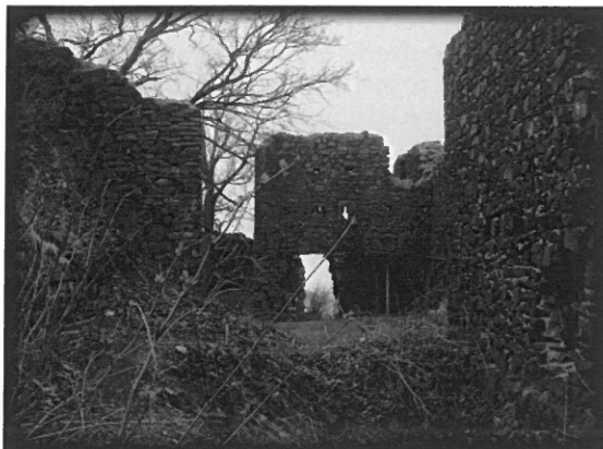
Pohled k jihozápadnímu objektu (5), vpravo u jeho zdi přístřešek, nad ním klíčová střílna, vlevo v popředí čedičový suk se zbytky paláce (3)
